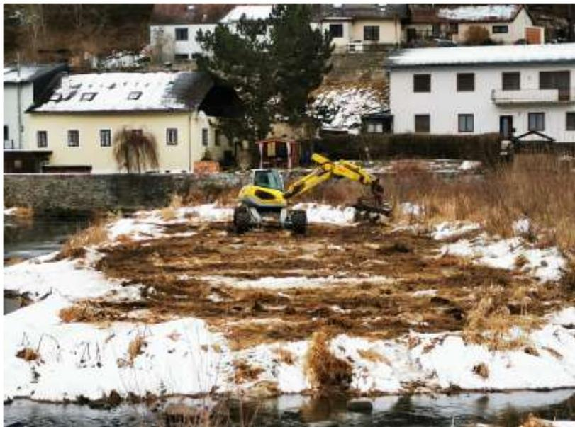
Die Mulcharbeiten für das Mitterland und unter der Brücke bei der Thaya in Kollnitzgraben wurden durch die Abteilung Wasserbau vom Land NÖ mit einem neuen Arbeitsgerät, Schreitbagger mit Mulcher, durchgeführt. Das Besondere daran ist, dass bei dieser Maßnahme kein Abtransport des Grünsaufwuchses erforderlich ist.
